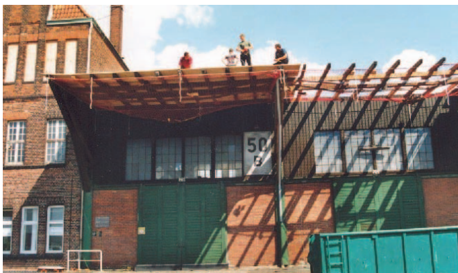
Eine Menge Holz – Beginn der Dacherneuerung im August 2003
